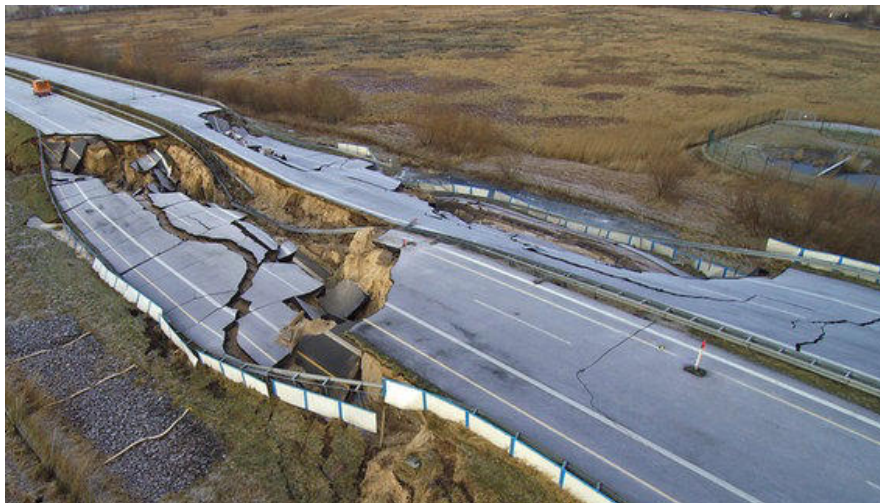
Abb. 1: Abgesackte A20
